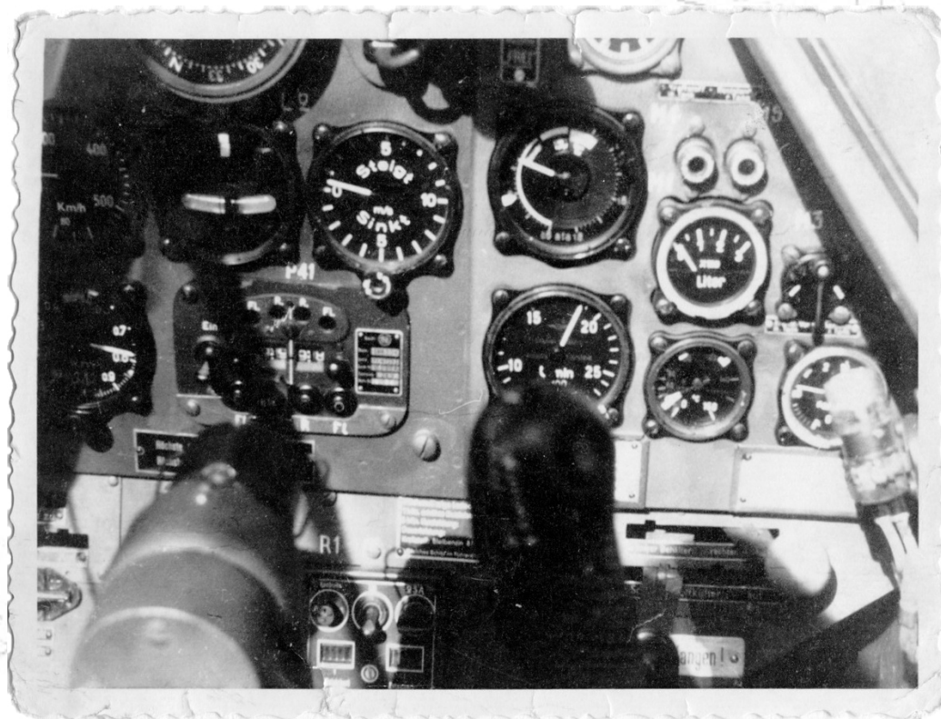
14. Instrument panel in the cockpit of an Arado Ar 196 A 14. Πίνακας οργάνων στο πιλοτήριο ενός Arado 196 A
